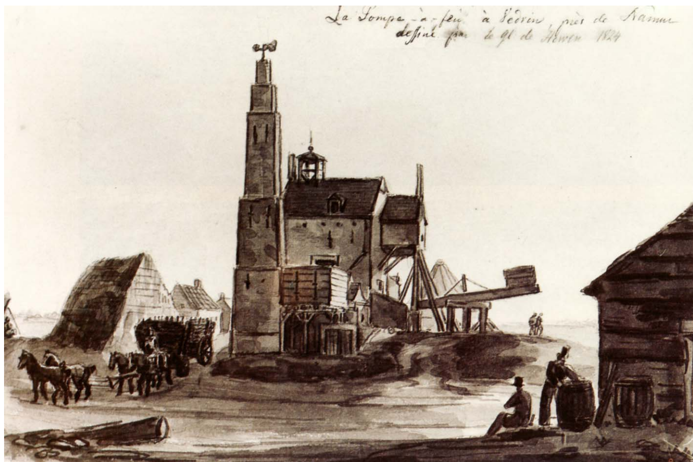
LA POMPE À FEU DE VEDRIN PRÈS DE NAMUR Dessin à l'encre rehaussé de lavis sépia et de blanc de plomb du général de Howen, daté de 1824 - 140x222 Collection privée
