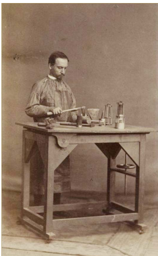
Léonard HALBART, Lampiste (l'éclairage des mines demande des lampes spécifiques, ici une lampe Muescher) - Baldaz-Lalore (charbonnage)
