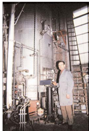
Richard Bellin surveille une des deux chaudières servant à fabriquer de la vapeur nécessaire pour le lavage des cruches, la pasteurisation, le chauffage, etc.
