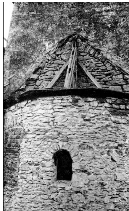
L'abside principale et son arc de décharge (1961).
