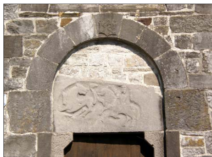
Linteau de remploi surmontant la porte d'entrée.
