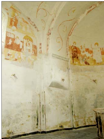
Arêtes et arcs retombent sur les piliers.
