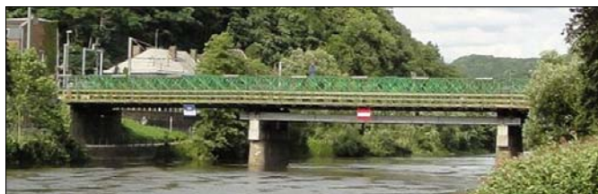
Le pont provisoire de Tilff.
