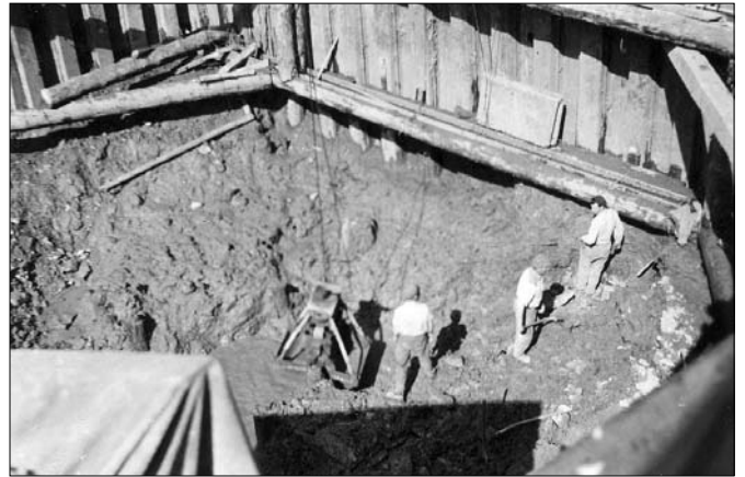
Batardeau de culée R.G. - le 16-4-1952.
