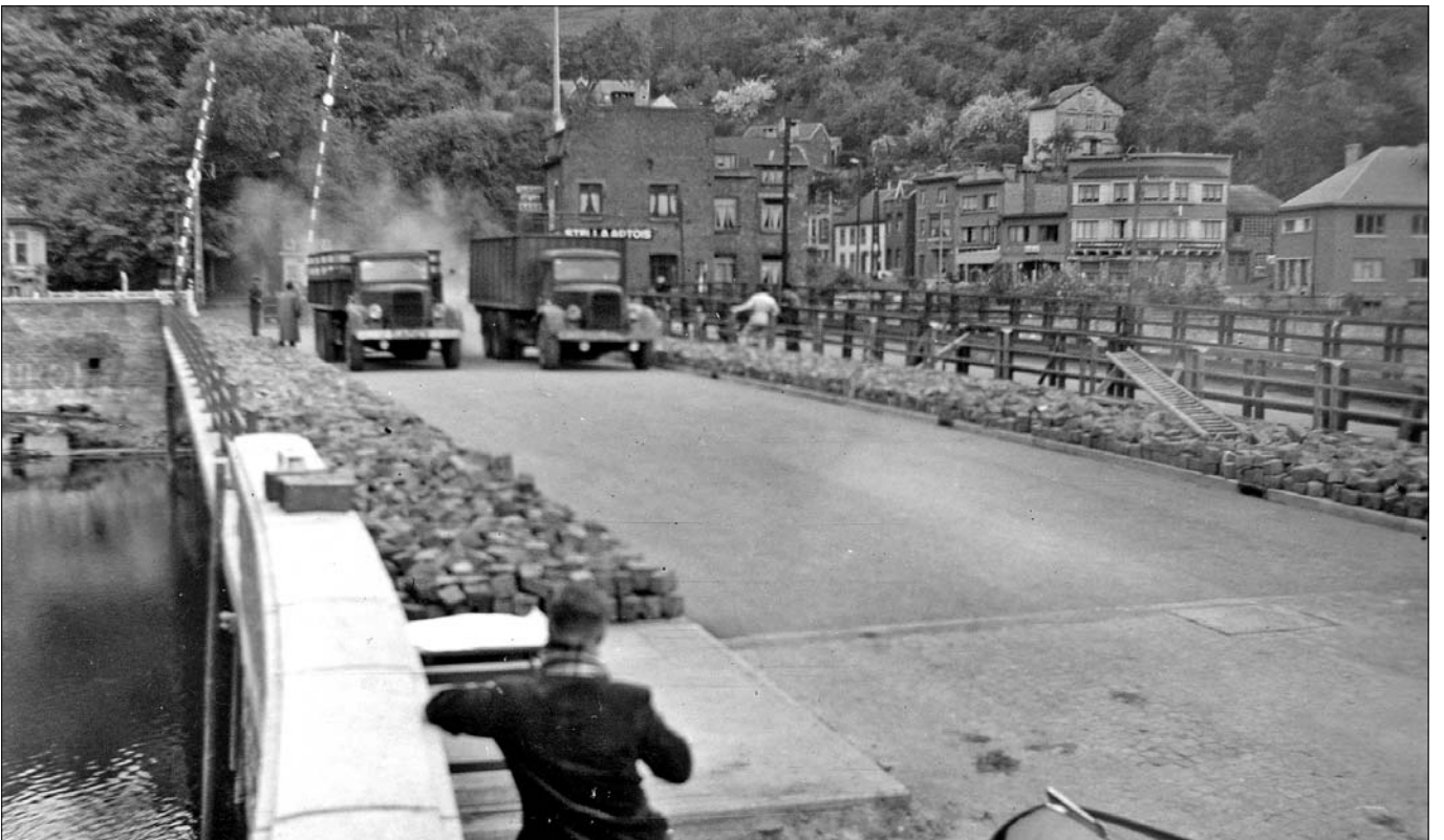
Essais du pont de Tilff le 7-5-1953 - Dernière phase : 2 camions de 24 tonnes en marche. (Les neuf photos réalisées par Jean Claes)
