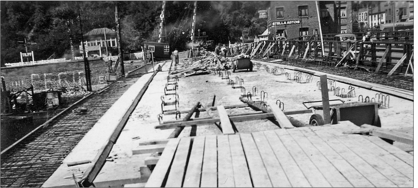
Démontage du pont provisoire de Tilff en mai 1953.
