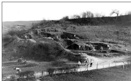
Tohogne - Chantier (sur «Greux») au début du siècle dernier.
