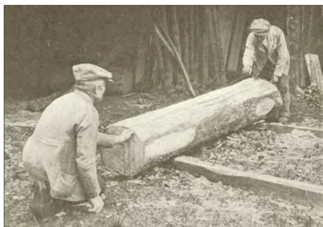
Marquage des traits longitudinaux sur le dessus du tronc.
