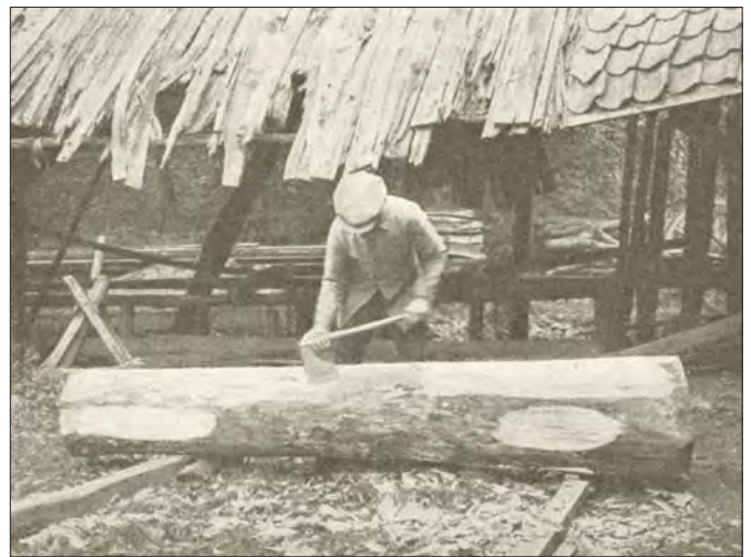
Le nettoyage du tronc. C'est dans la même position qu'il sera placé sur le hourd pour être scié. Les deux fâzès haches sont visibles.
