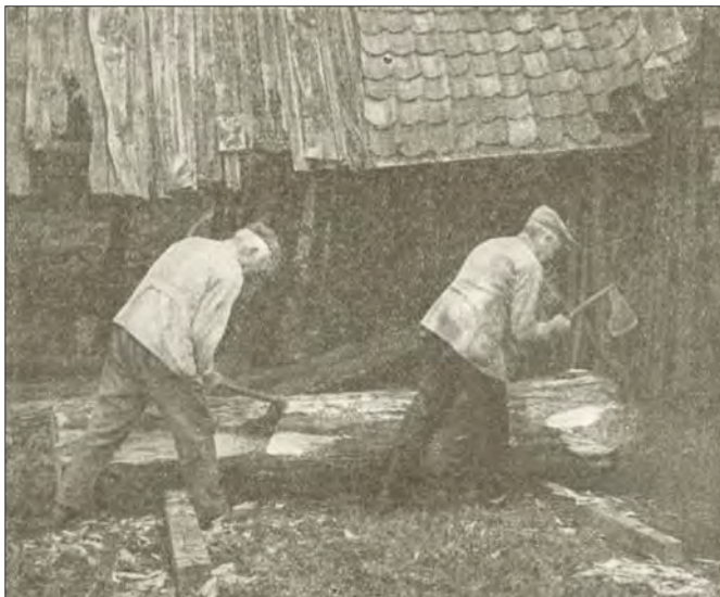
L'équarrissage Le tronc repose sur les fâzès haches . - Bilstain, 1942.
