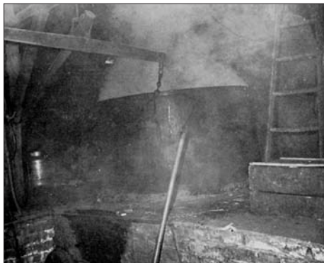
Chaudière sur le foyer et palan.
