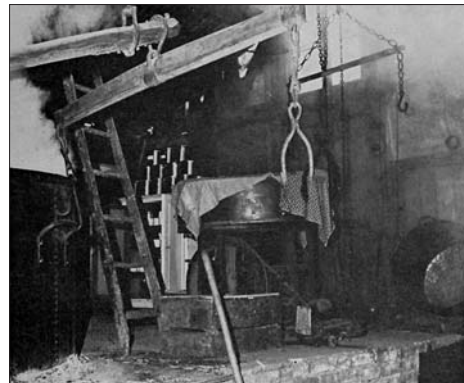
Refroidisseur, mû électriquement.
