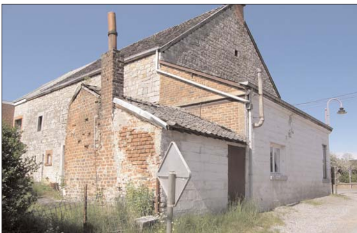
Endroit exact où se situait l'ancienne siroperie.
