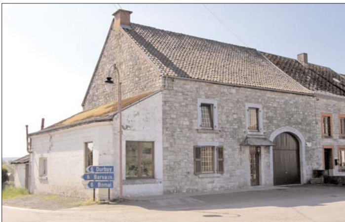
C'est au fond de l'appentis blanc de cette maison (au 96, rue de Presseux) que se situait la siroperie.
